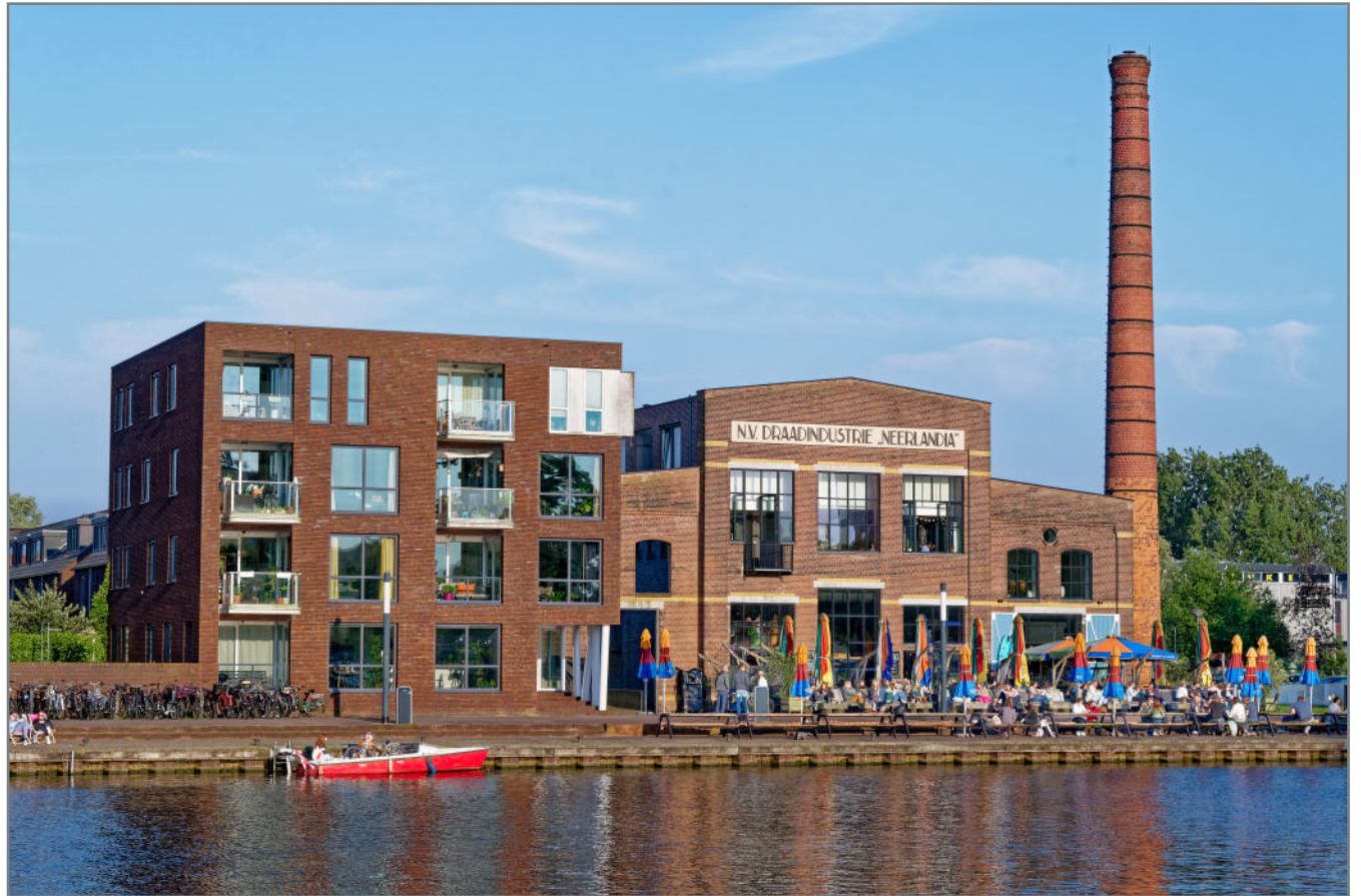
Nieuw en oud bij de voormalige draadnagelfabriek
